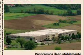
Panoramica dello stabilimento
